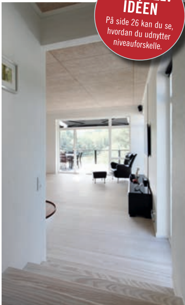
Trappen af Douglasfir og ditto gulve fører ned til dagligstuen og terrassen. Loftshøjden er øget til tre meter, efter at kælderen blev fyldt op.
